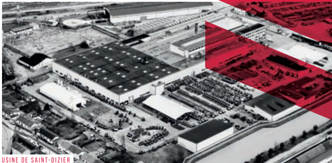
USINE DE SAINT-DIZIER
