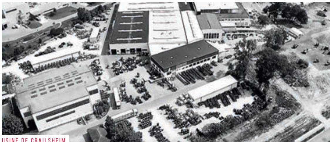
USINE DE CRAILSHEIM
